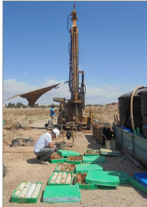
Figura 27. Imágenes de la construcción de los sondeos litológicos.
